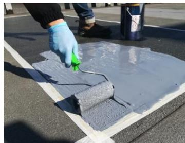
Sobre membrana asfáltica
