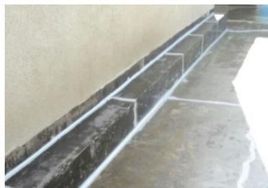
Desagüe entre losa y sobrelosa
