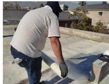
Malla sobre hormigón muy fisurado
