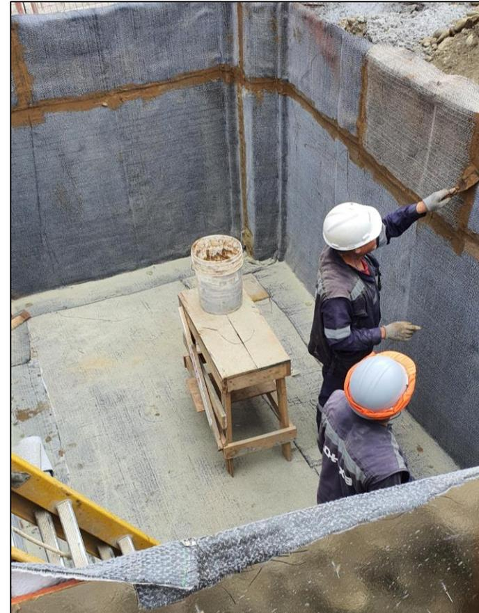
LA CORRECTA DISPOSICIÓN DE LA MANTA PERMITE UNA ADHERENCIA EXCELENTE AL HORMIGÓN, LIMITANDO DESPRENDIMIENTOS POR ASENTAMIENTOS.
