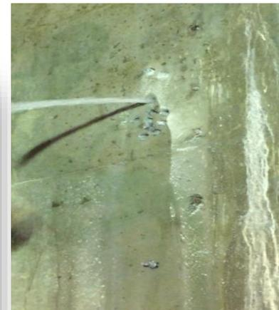
**MLA Resistencia = La capacidad de la membrana para evitar que el agua viaje entre la membrana impermeabilizante y la estructura**
